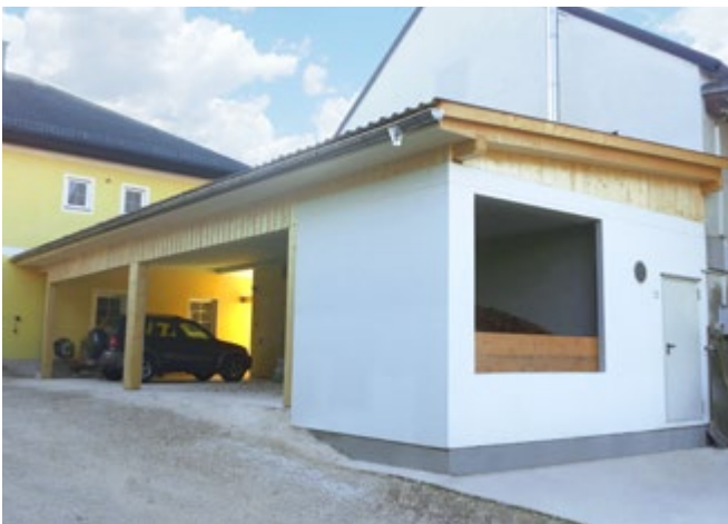
Einstock-Heizmodul bei einem Bauernhof
