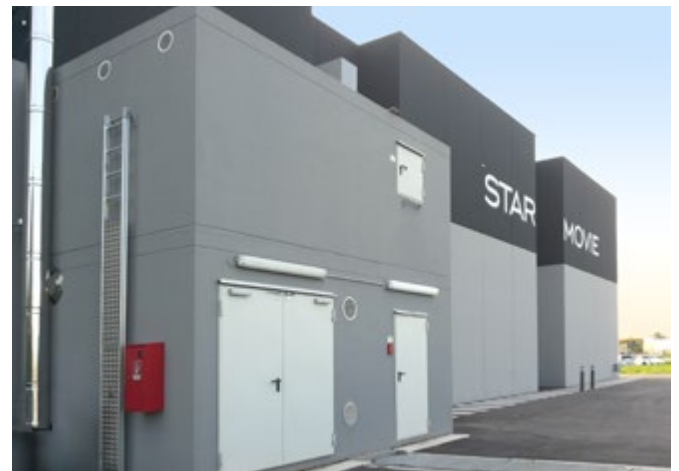
Doppelstock-Hackgut-Heizmodul neben öffentlichem Gebäude.
