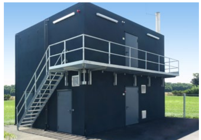
Vierfach-Hackgut-Heizmodul bei einem Industriegebäude.
